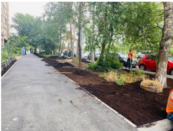
Ремонт тротуаров вдоль ул. Фруктовая
