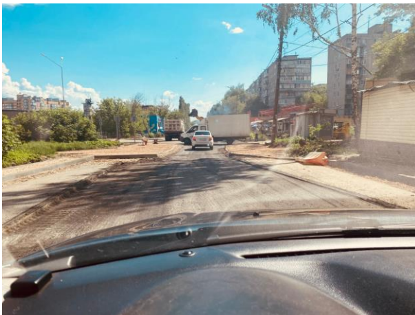
Ремонт дороги по ул. Фруктовая
