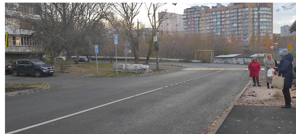
Ремонт дороги ул. Усилова
