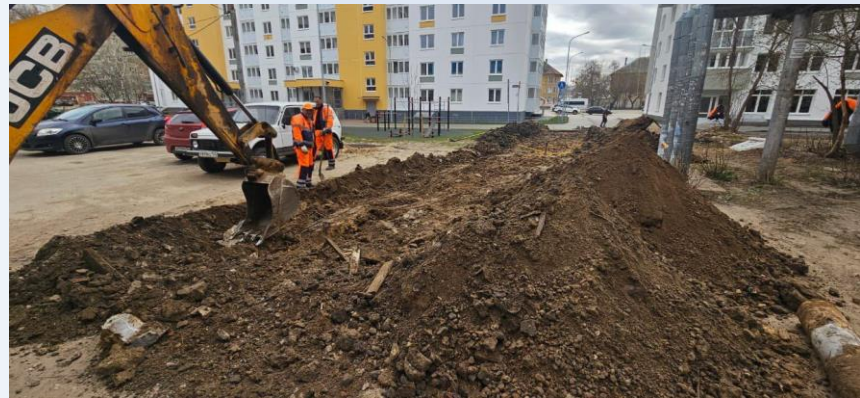
Восстановление благоустройства у домов №№31А, 33А по ул. Героя Васильева
