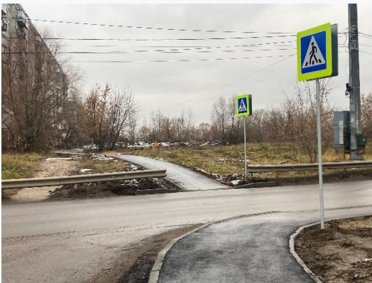
Благоустроенный переход на ул. Ермоловой
