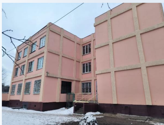
Выделены средства на ремонт рустов здания школы №190
