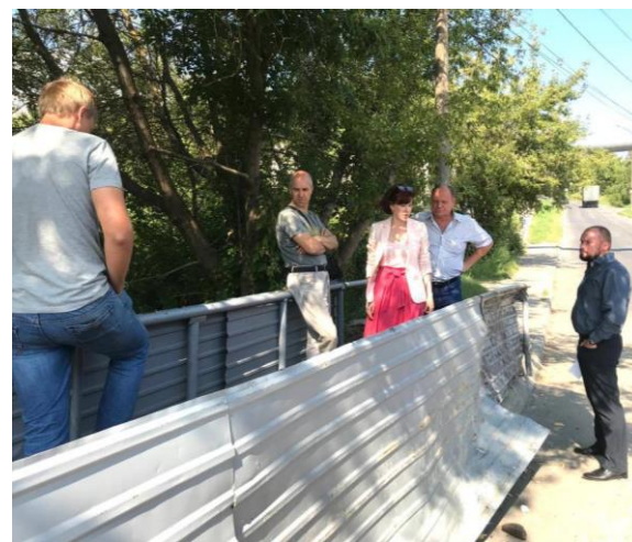
Ремонт пешеходного мостика на ул. Яблоневая
