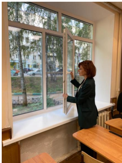
МБУ ДО «ДДТ Нижегородского района ЦДТ «Успех» Замена стеклопакетов
