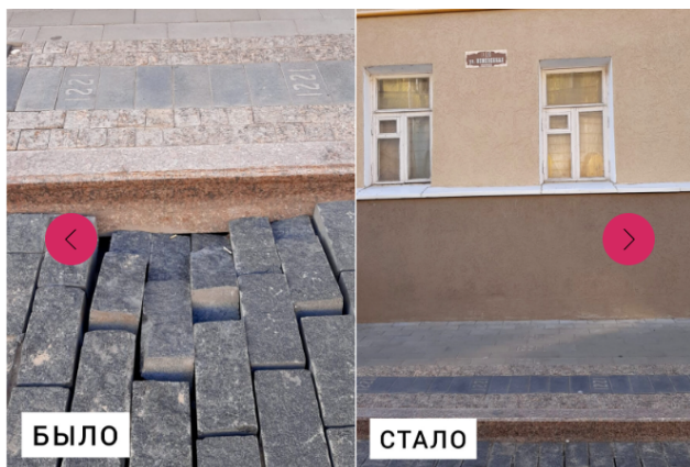
улица Кожевенная, 5 – после обращения жителей в депутатскую приемную около дома отремонтировали брусчатку
