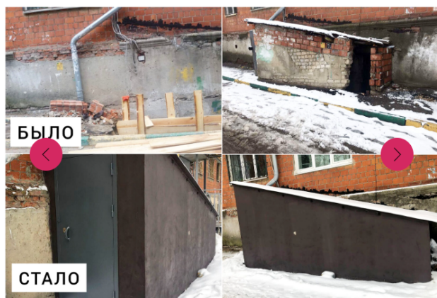
улица Малая Ямская, 66 – отремонтировали аварийный вход в подвал
