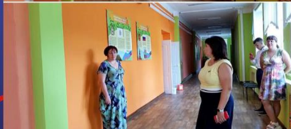
ШКОЛА 33 – РЕМОНТ КОРИДОРА ВТОРОГО ЭТАЖА
